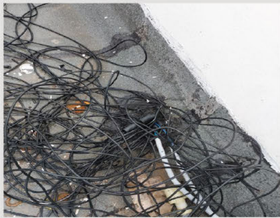
صورة #6: التمديدات المكشوفة على السطح
